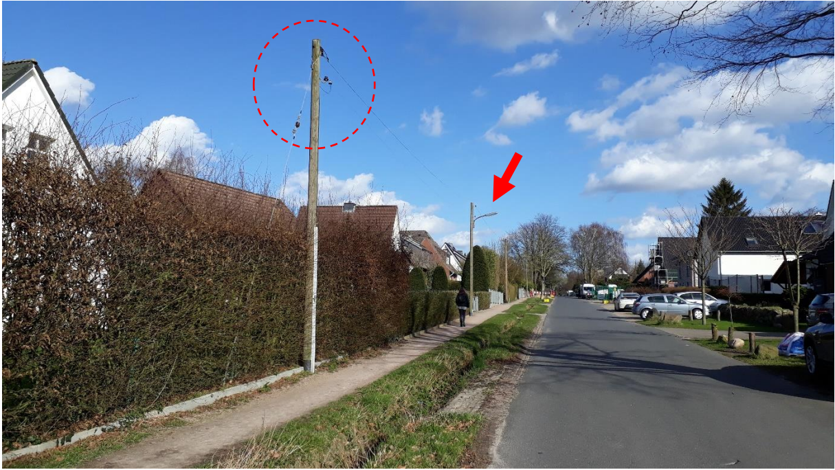
Bild 3: Nur jeder 2. Laternenmast verfügt über einen Beleuchtungskörper
