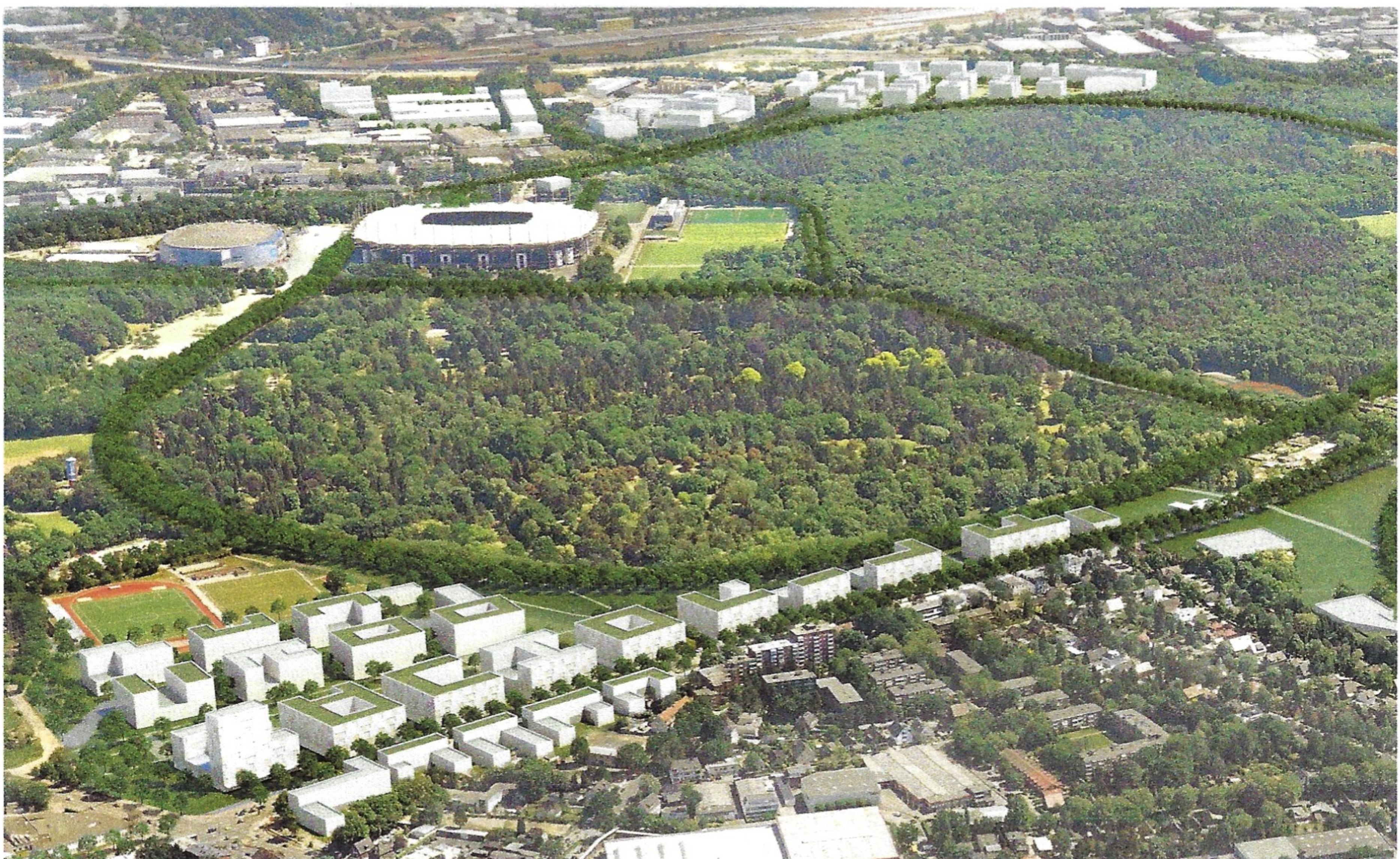
Abb. 37: Luftbildvisualisierung mit geplantem Forschungs- und Innovationspark Altona (Quelle: FHH, BSW/Spengler Wiescholek Architekten Stadtplaner, Urban Catalyst GmbH, WES GmbH Landschaftsarchitekten, moka-studio GbR, Januar 2019)
