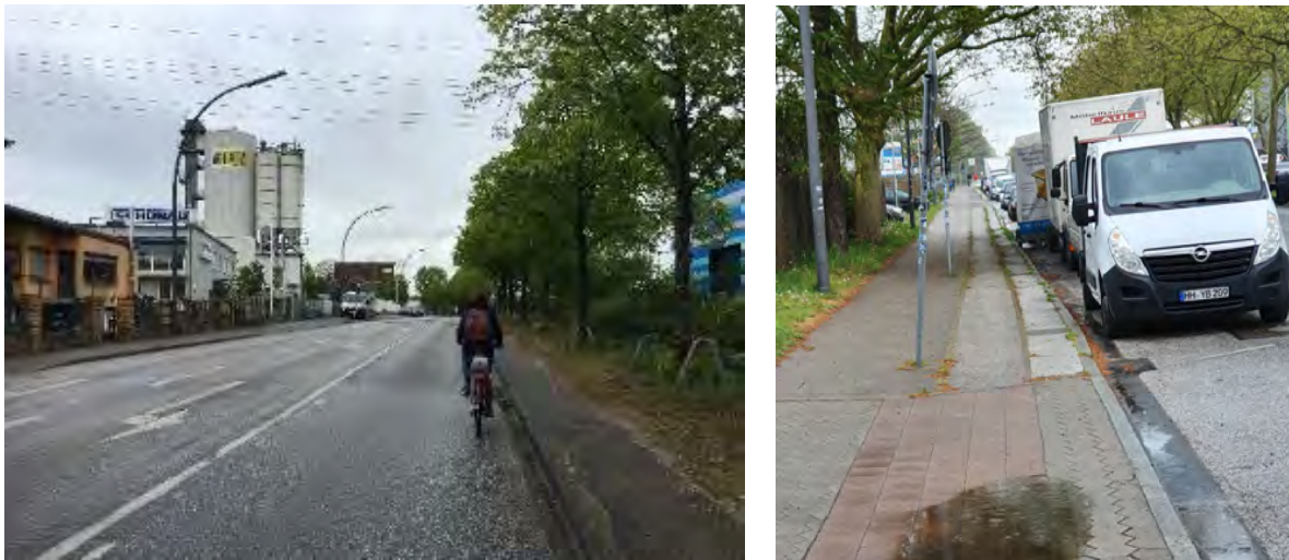
Abbildung 43: Beschädigte, verbaute und unterdimensionierte Radwege am Standort
