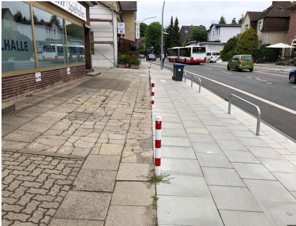
Die Gehwegplatten sind nicht zum Überfahren ausgebildet. Um das Überfahren zu verhindern, mussten Bügel und Poller gesetzt werden.
