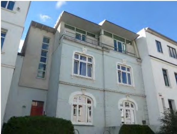
Abb. 9: Dachausbau eines Stadthauses
