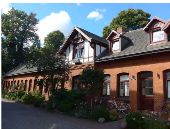
Abb. 6: Gebäude der Köster Stiftung
