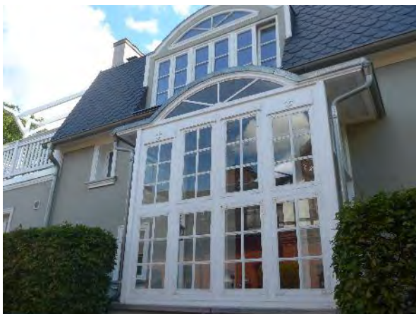
Abb. 11: Prägende Originalfenster mit Sprossen
