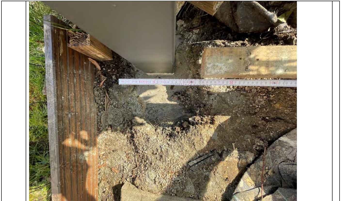
Hier 2 Beispielbilder (nur zum verdeutlichen) von Fundamenten für die Pfosten, die Größe ca. 40x40x80 cm (B x L x H) könnte ähnlich erfolgen.
