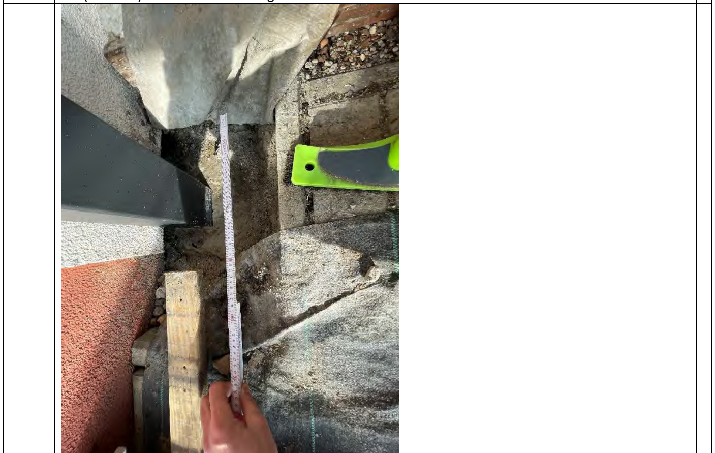
Hier 2 Beispielbilder (nur zum verdeutlichen) von Fundamenten für die Pfosten, die Größe ca. 40x40x80 cm (B x L x H) könnte ähnlich erfolgen.
